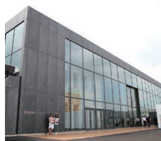
敦賀駅交流施設 オルパーク
